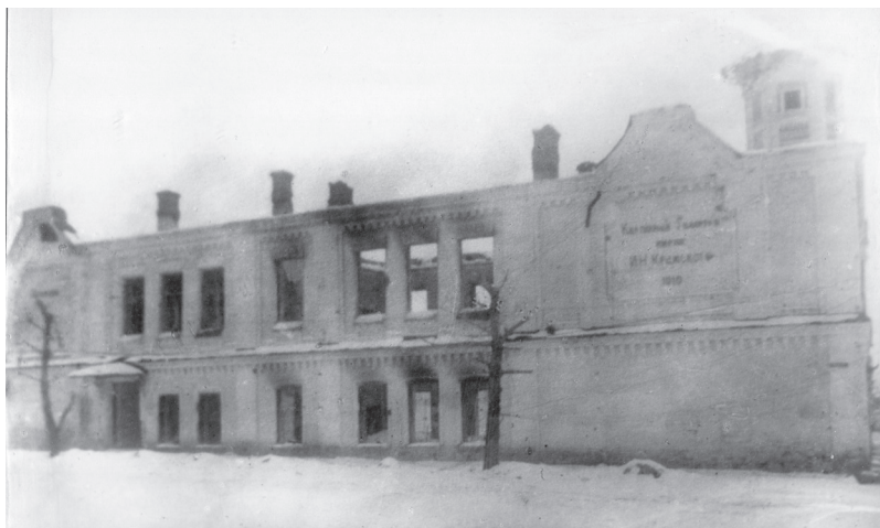
Полуразрушенное здание картинной галереи им. И. Н. Крамского
